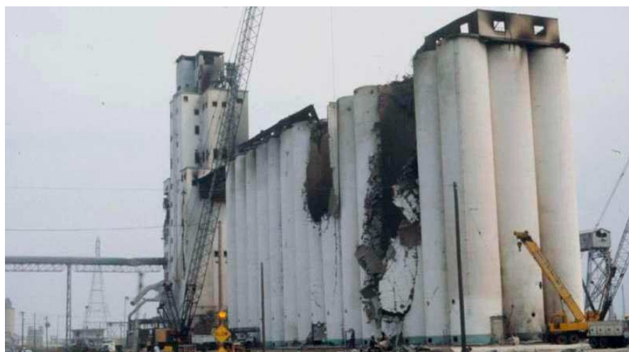
Последствия взрыва мучной пыли на элеваторе
